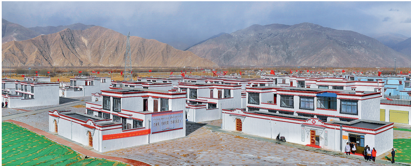
Eine neue Siedlung in den Vororten von Lhasa steht für Familien zur Verfügung, die aus den benachbarten hochgelegenen Gebieten mit schlechten Lebensbedingungen umsiedelten. JIANG GAI / FÜR CHINA DAILY
